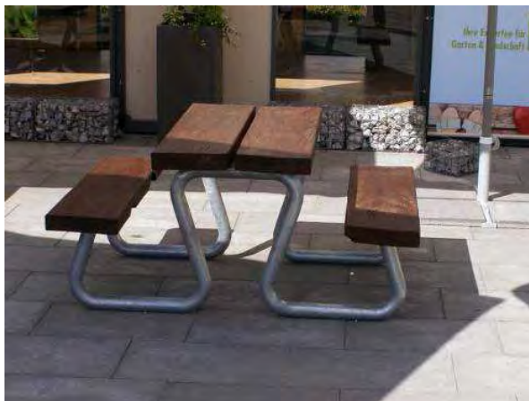
Attēlā piknika galda piemērs – metāla liektas kājas un koka dēļu galda virsma un solu sēdvirsmas.
