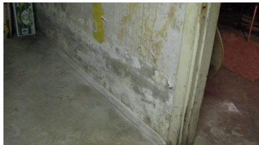
4.1.6.att. Mitruma plankumi uz siltummezgla sienas no gaiteņa puses.
