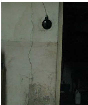
4.20.1.att. Plaisa pašnesošajā sienā gaitenī pie apkopējas telpas
