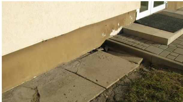
4.8.1.att. Apmales deformācijas un iesēdumi pie ieejas.
