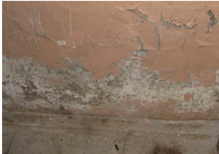
4.1.16.att. Mitrā telpā uz grīdas un sienām mitruma radīti melni plankumi, apdare nolobījusies.
