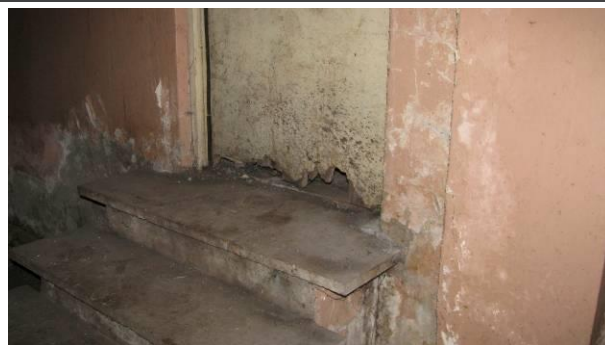
4.1.24.att. Siena un kāpnes mitras, durvis bojātas mitruma ietekmē
