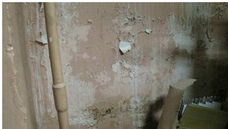
4.1.17.att. Uz sienas mitruma radīti melni plankumi, apdare nolobījusies.
