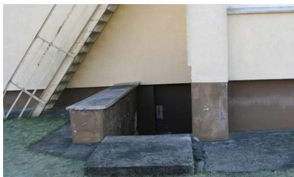
4.1.3.att. Cokols ar mitruma plankumiem pie āra kāpnēm uz pagrabu. Zemes līmenis augstāks par apmali.
