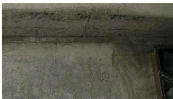
4.1.21.att. Griesti ar melniem un zaļiem mitruma radītiem plankumiem.
