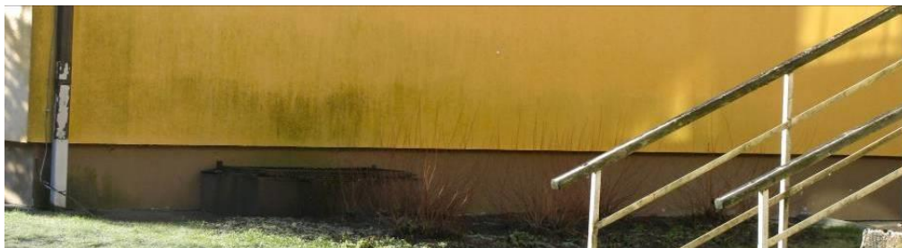
4.19.7.att. Uz sienas 1.korpusa ziemeļu pusē redzami mitruma radīti plankumi.
