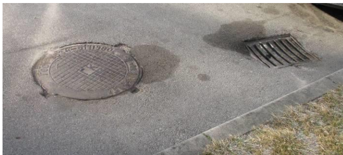
4.8.4. Lietus ūdens kanalizācijas aka un gūlija nokrišņu ūdens savākšanai no teritorijas
