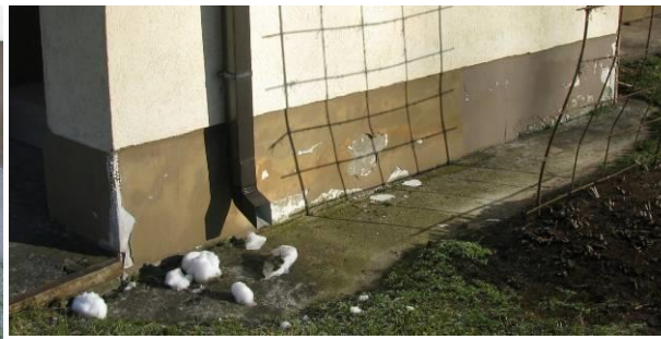
4.1.2.att. Apmale ar zaļiem plankumiem, cokalam nolopusi apdare.
