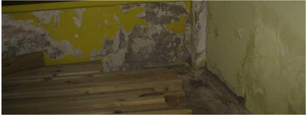
4.1.15.att. Pagraba stāvā zem 2.korpusa galvenajām kāpnēm siena ar mitruma plankumiem, nolobījusies krāsa .
