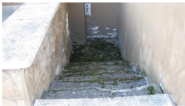
4.1.4.att. Āra kāpnes uz pagrabu apsūņojušas, sienas mitruma ietekmē nolupušas
