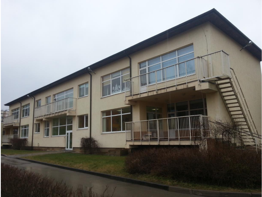
Ekspluatācijas laikā ēkai tika veikti jumta seguma remontdarbi un izveidots divslīpju jumts ar ārējo lietus ūdens novadīšanas sistēmu.
