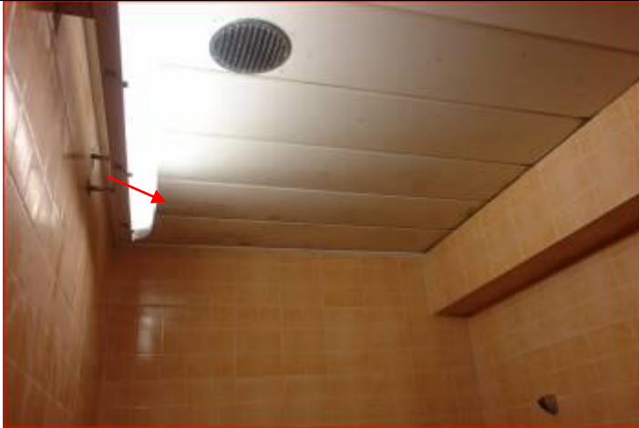
Problēmas ar ventilāciju dušas telpās. Pelējums pie griestiem.
