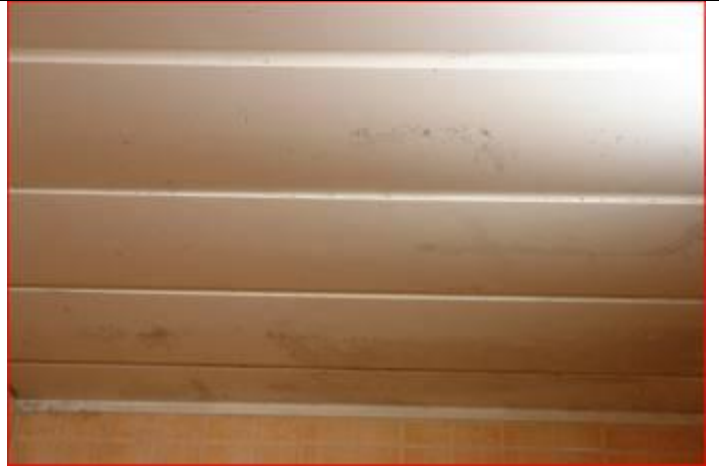
Problēmas ar ventilāciju dušas telpās. Pelējums pie griestiem.
