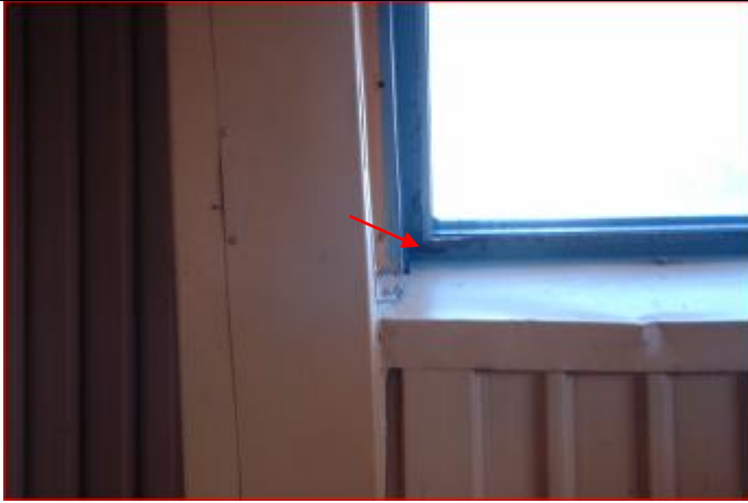
Stāvā esošais alumīnija profila logs. Profils ir bojāts stūrī, kas veicina siltā gaisa eksfiltrāciju no iekštelpām.
