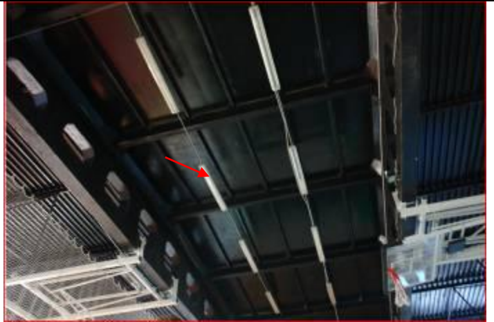
Sporta nama jumta pārsegums. Dzelzsbetona nesošās konstrukcijas, metāla loksnes.
