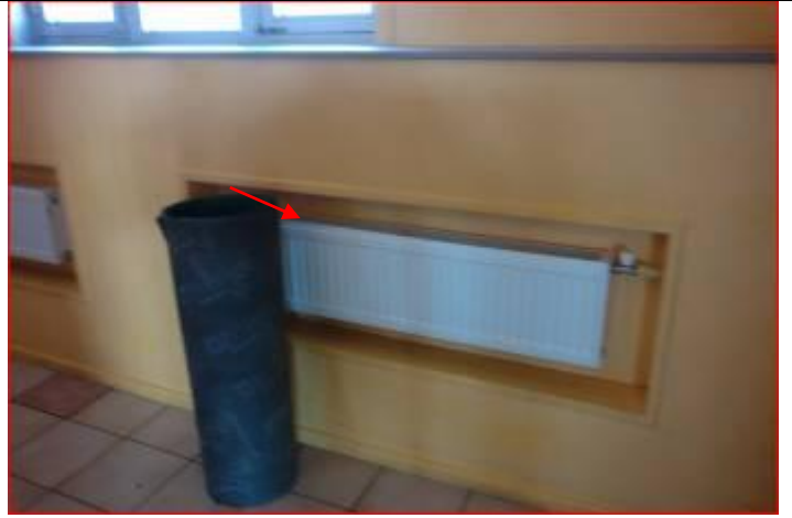
Daļa no iekštelpu radiatoriem ir mainīta uz jauniem ar regulēšanas vārstiem.
