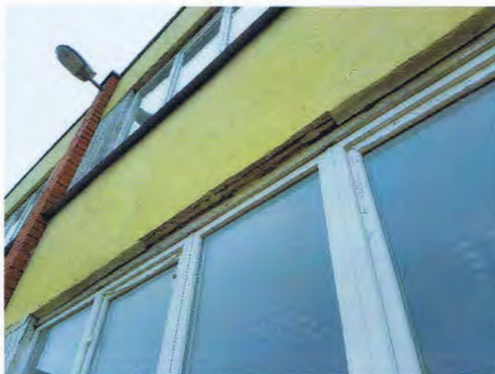
F-8. Ārsienu vieglbetona paneļa izdrupums, atsedzot stiegrojumu
