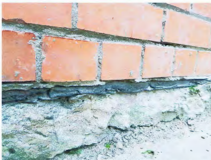
F-9. Horizontālā hidroizolācija
