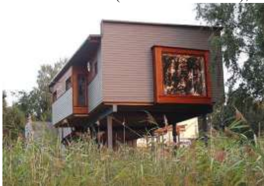
13.attēls. Māja uz pāļiem.
