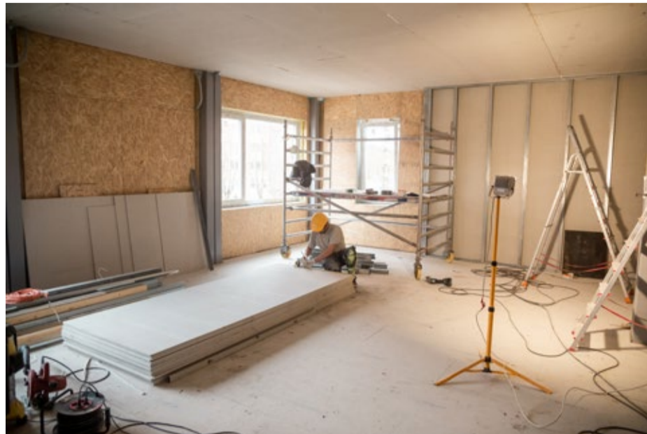
Uzsākti iekšdarbi piebūves otrajā stāvā.
